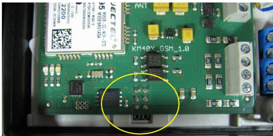
Rys.3 Zamontowanie płytki w liczniku Kamstrup 402 (należy zostawić 2 gniazda wolne, moduł ma być odsunięty od ścianki licznika)
